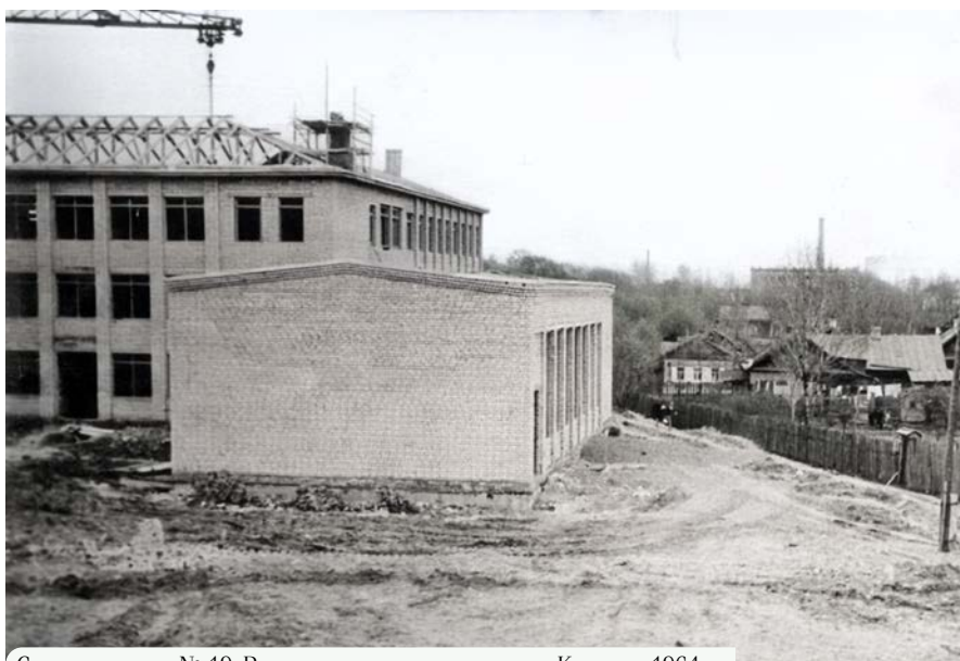
Строится школа № 19. Видны деревянные дома на ул. Каляева. 1964 г.
